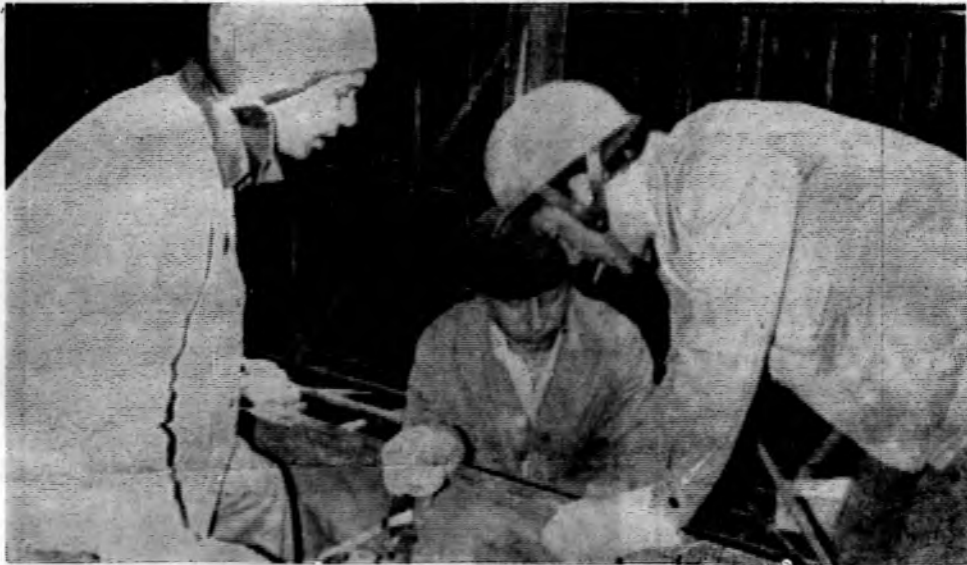
Бригада И. Лазарева успешно трудится на строительстве рентгенокамеры. На снимке: В. ТИВИНОВ, Н. КРЕТОВ, В. ЧУДИНОВ устанавливают опалубку. Фото С. Лейкина.
